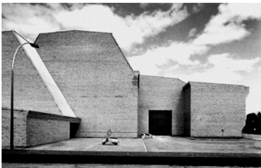
Instalaciones de Diestre en la carretera de Madrid, 1964. Considerada la primera obra de Rafael Moneo (Premio Pritzker, 1996). Actualmente las instalaciones las ocupa la empresa de transformadores ABB. Foto L'Architecture d'Aujourd'hui , 1967.
