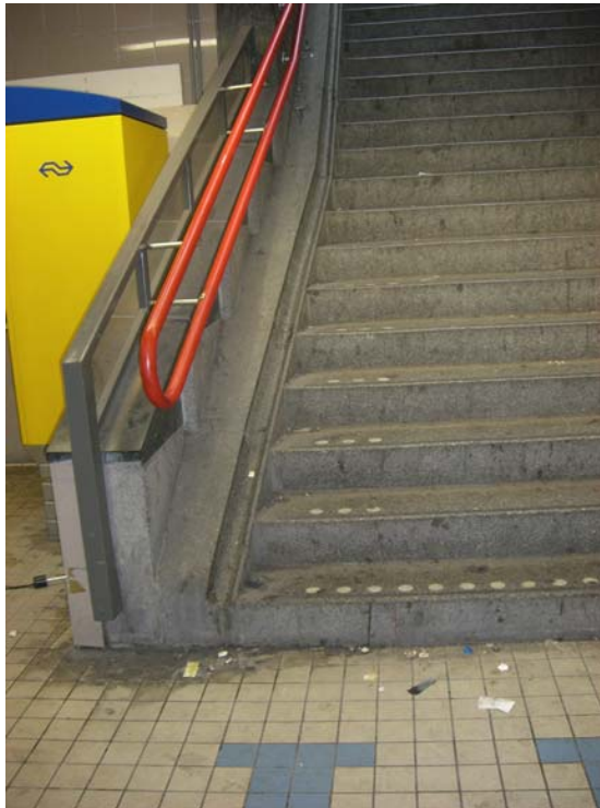
Canaleta en escalera para acceso a estación de transporte.
