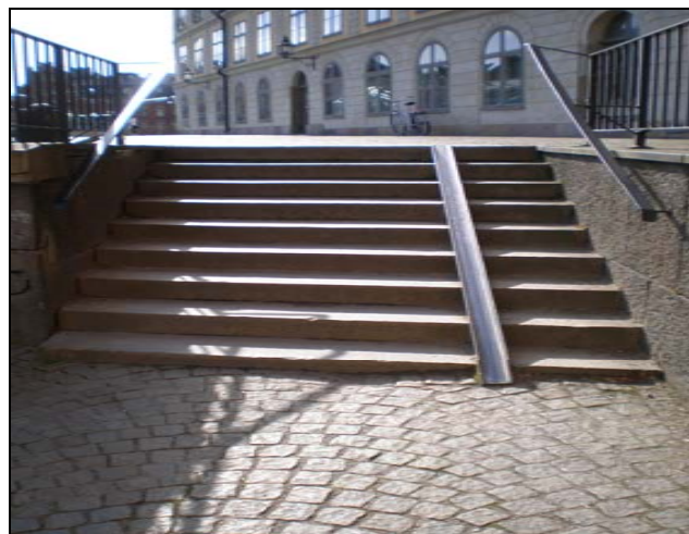
Canaleta en Suecia Fuente: Idom
