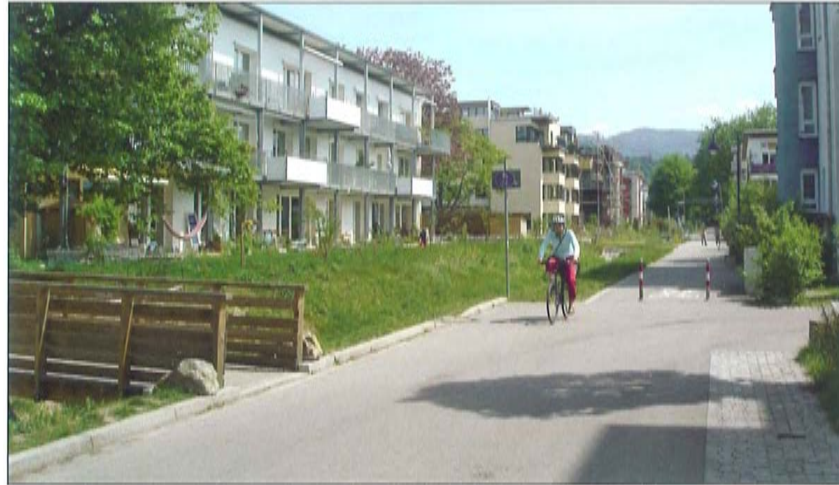
Carril bici con control de acceso mediante pivotes Fuente: "Calmar el tráfico". Ministerio de Fomento.
