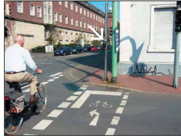
Semáforo específico para ciclistas para giro a la izquierda en dos tiempos.
