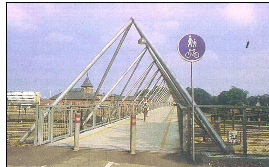
Puente peatonal y ciclistas sobre el haz de vías de una estación ferroviaria en Copenhague.
