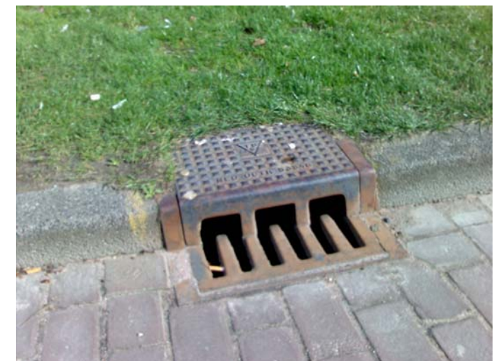
Imbornal con carga vertical y horizontal situado junto a zona verde.
