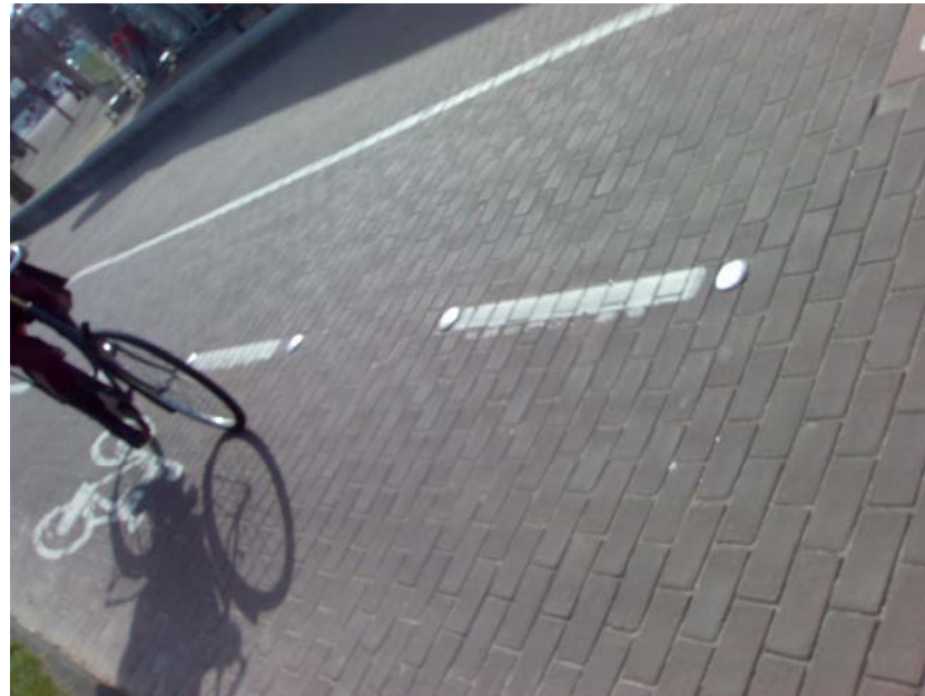
Ejemplo de posible elemento delimitador. Chinchetas colocadas en el pavimento.
