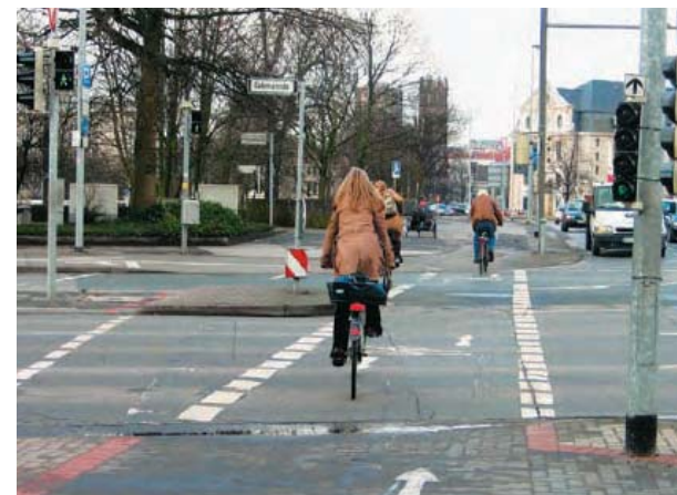
Cruce ciclista sobre calzada con semáforo específico para ciclos.
