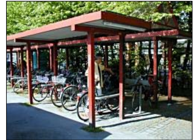
Estacionamiento de bicis protegido mediante cubierta metálica.
