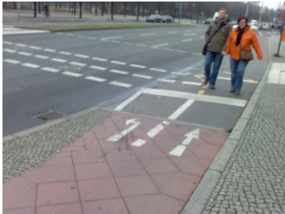
Ejemplo de zona de espera para cambio de dirección en vía ciclista.
