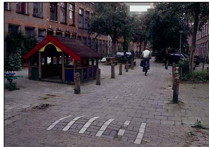
Cambio de rasante brusco en calle peatonal
