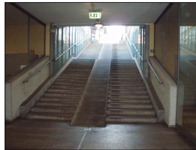
Rampa en las escaleras en Münster Fuente: Idom
