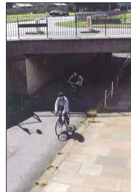
Paso inferior en Stevenage.
