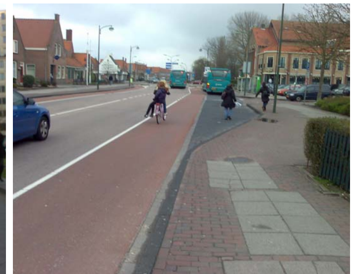
Ejemplo de carril bici por delante de parada de transporte público
