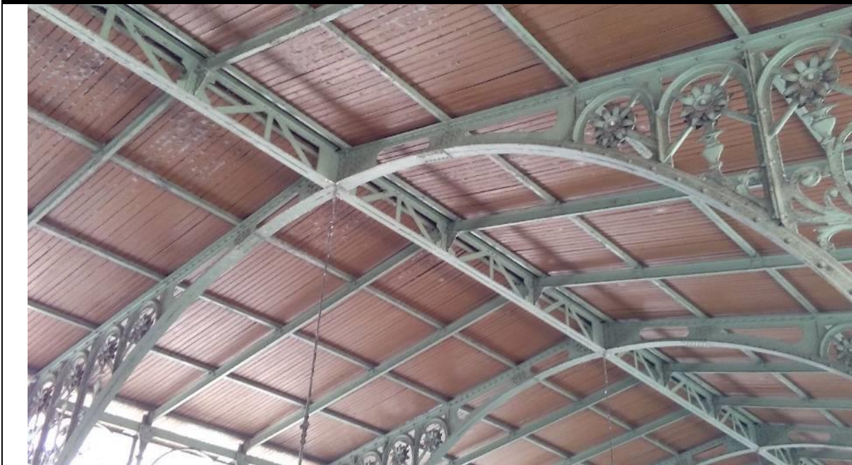
Situación: Planta 1ª. Correas centrales superiores entre pilares interiores lado este
