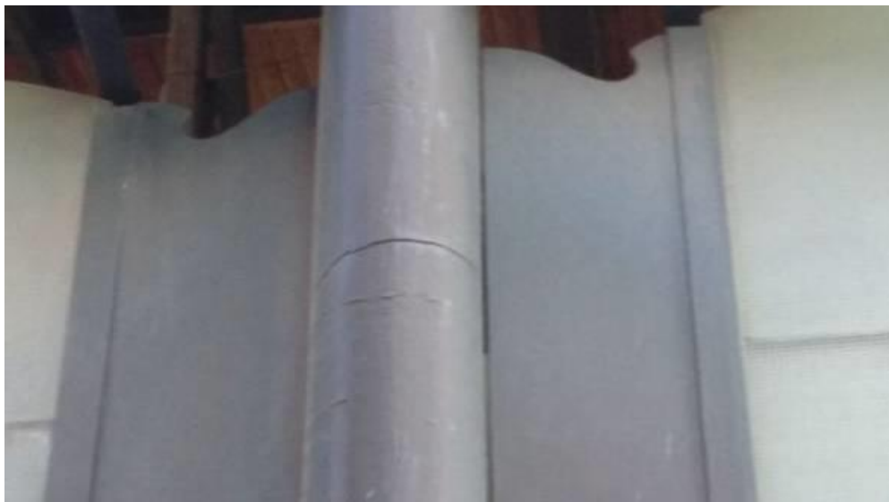
Fractura aparentemente en todo el contorno
