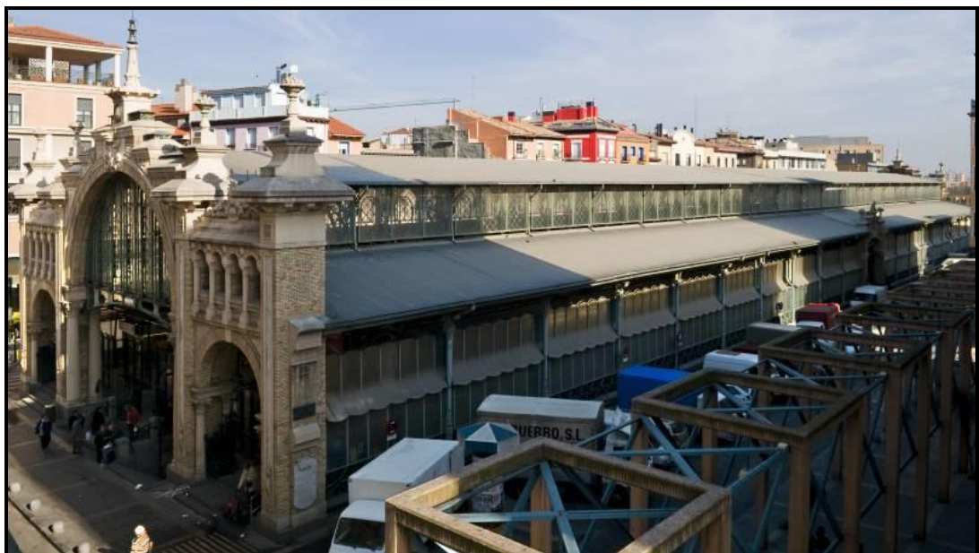
Vista general de la cubierta
