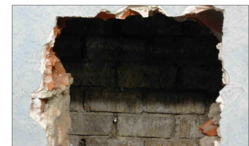
F1: Muro perimetral de sótano
