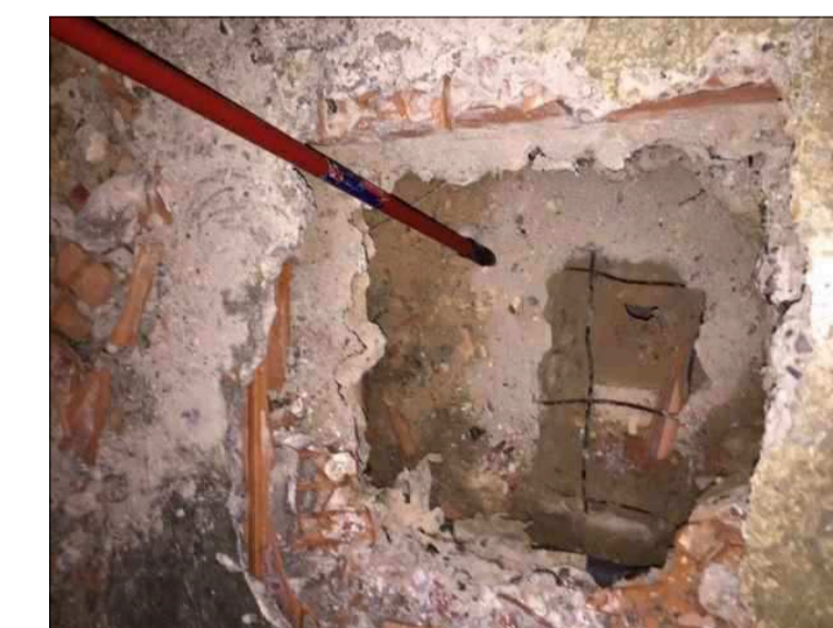
F3: Forjado descubierto
