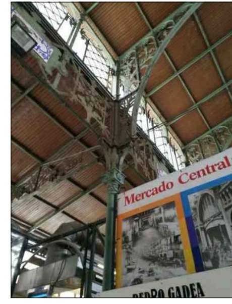
F3: Cubierta ala este
