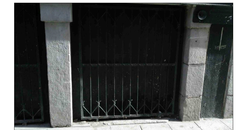
F5: Muro perimetral y reja
