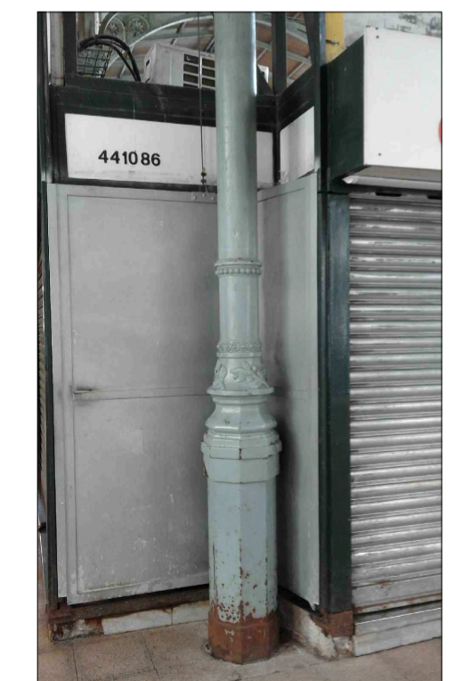
F5: Pilar central de fundación
