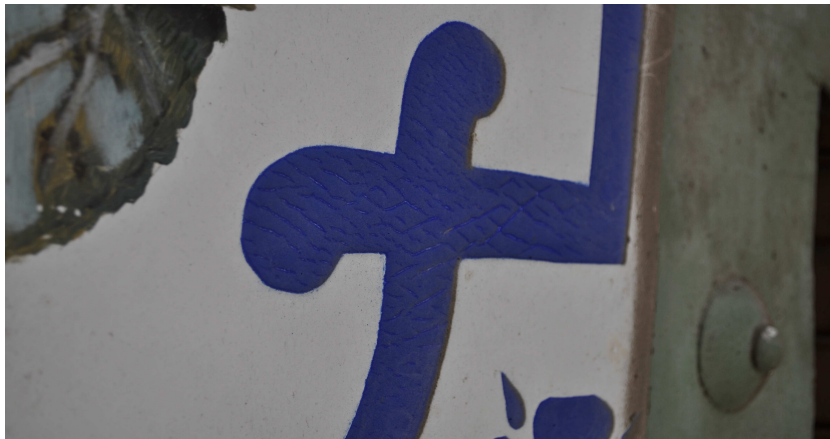
Microfisuras del esmalte azul.
