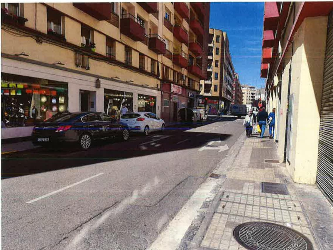
En este tramo las aceras tienen una anchura de aproximadamente 1,5 m y la calzada tiene dos carriles de circulación en el mismo sentido, este a oeste, y un banda de aparcamiento en línea con una anchura total de unos 6,5 m.
