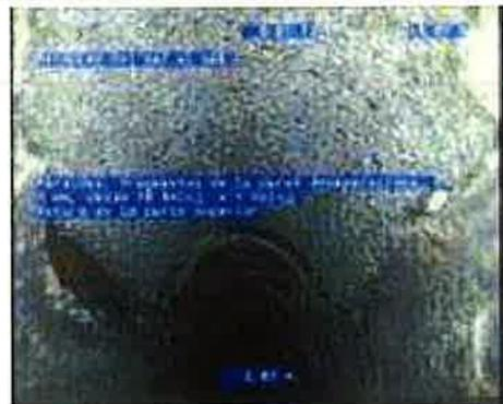
A 7,36 m: Fisura abierta longitudinal por la parte superior del tubo, a las 11:00 h. Anchura aproximada de la fisura 1,00 mm.
