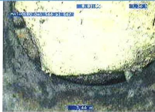
A 4,31 m: acometida Ø200 mm a las 12:00 h. Se observan fisuras en el codo de conexión de la acometida.
