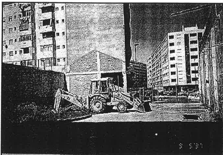
Máquina retroexcavadora durante la realización de la calicata C-2.
