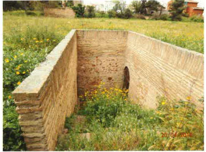
Antiguo acceso a depósito
