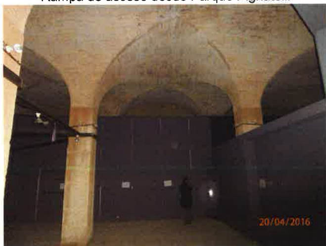
Pilastras y bóvedas de cubierta del depósito
