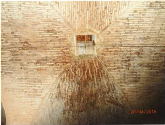
Bóveda arista con lucernario en la clave
