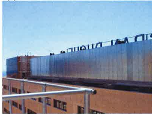
Figura 04. Detalle de la instalación de pantalla
