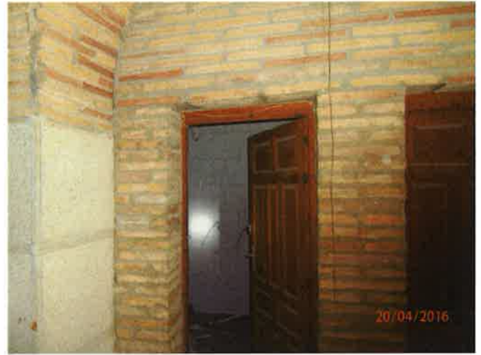
Aseos existentes en la entrada
