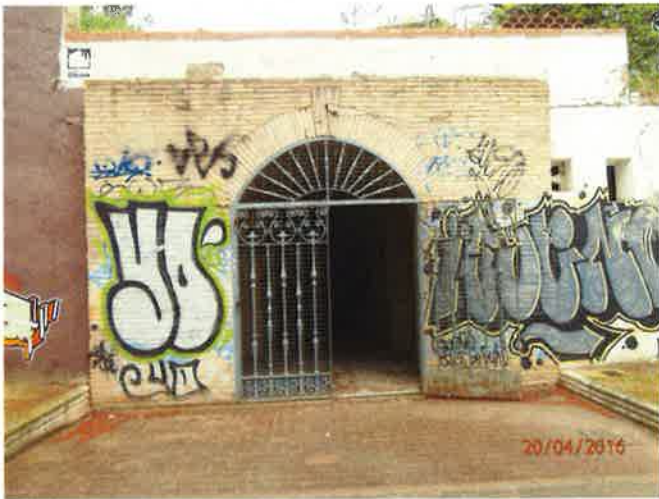
Acceso a depósito cubierto
