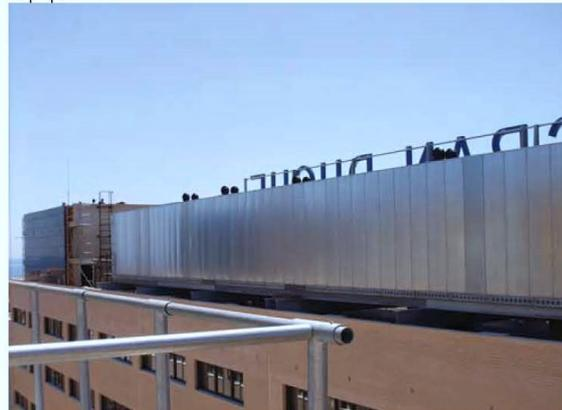
Figura 04. Detalle de la instalación de pantalla
