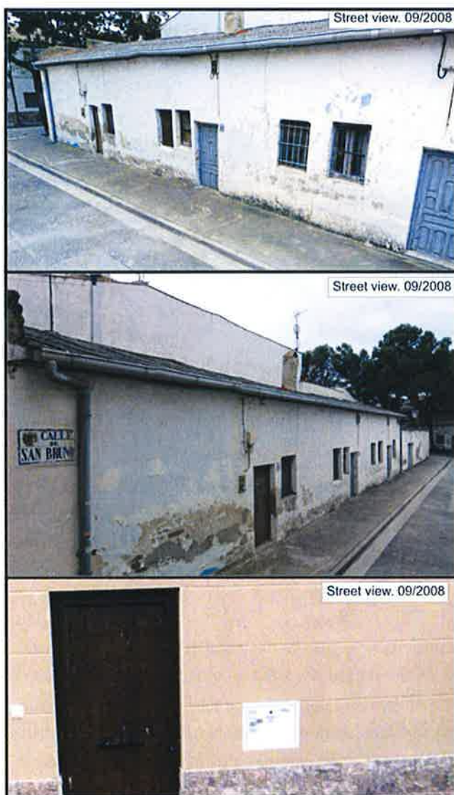
Figura 4. Imágenes de la zona de estudio obtenidas de street view de Google para fotografías realizadas en septiembre de 2008.
