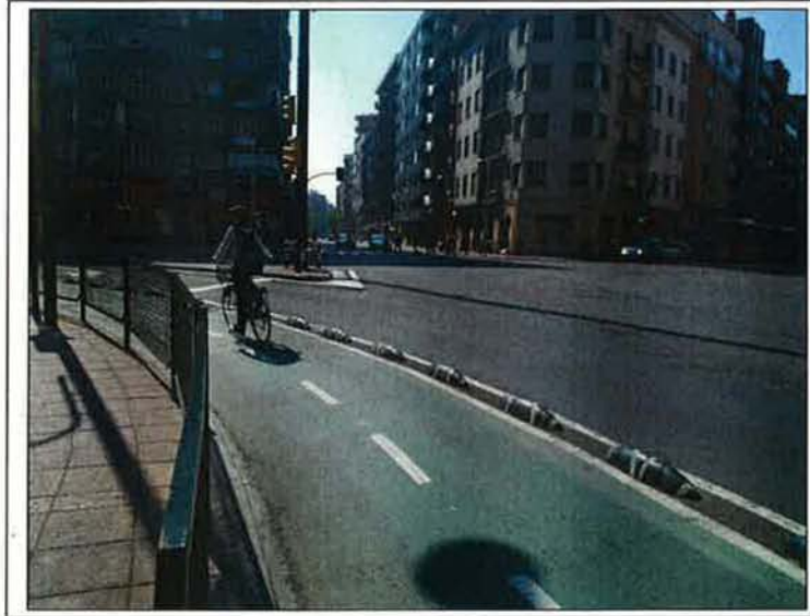
Carril bici segregado del tráfico en la C/Miguel Servet
