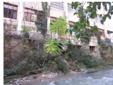
Afecciones al edificio del C.D.M. Salduba, en margen derecha, de las avenidas de 2003 y 2007. Se aprecia el descalce de algunos pilares.
