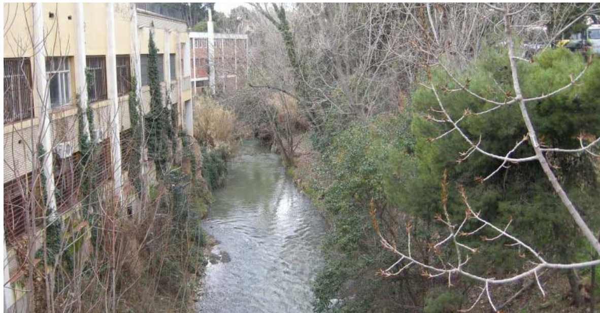
Instalaciones CDM Salduba ocupando espacio del cauce del río
