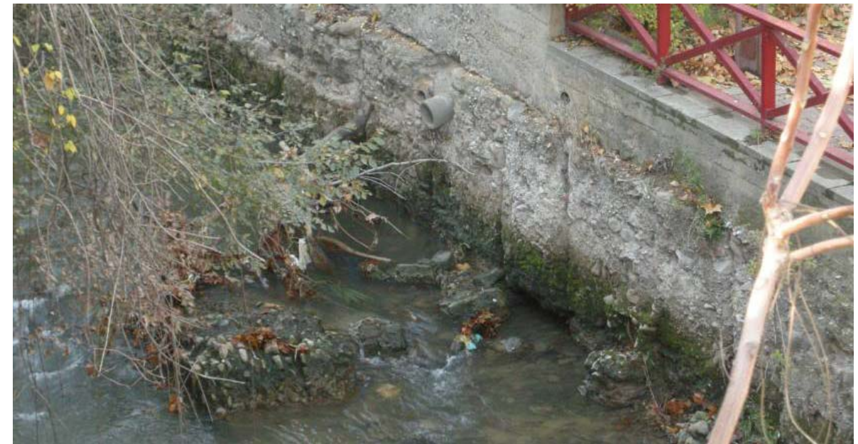
Instalaciones C.M. Pedro Laín Entralgo ocupando el espacio fluvial.
