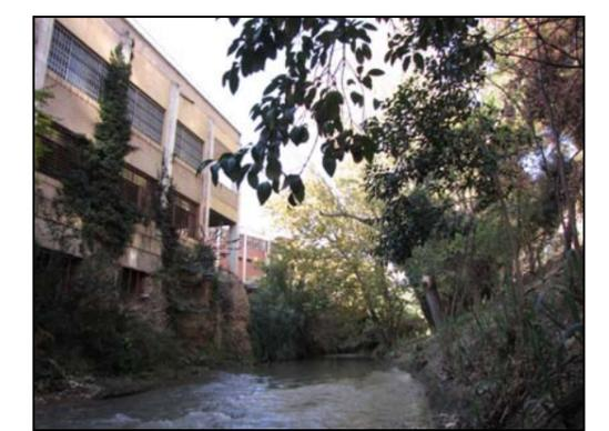
*Edificio del C.D.M. Salduba apoyado sobre los niveles de gravas cementadas de margen derecha*
