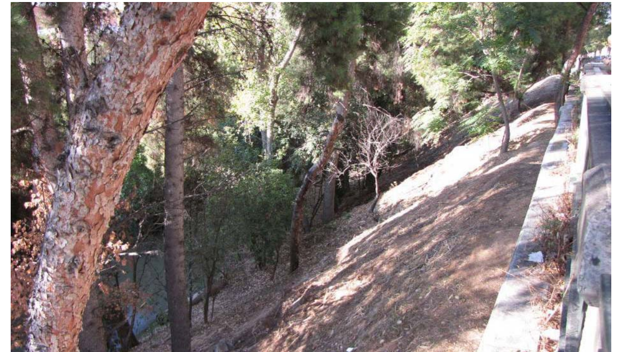
Talud existente en el que se observa el mal estado de la vegetación
