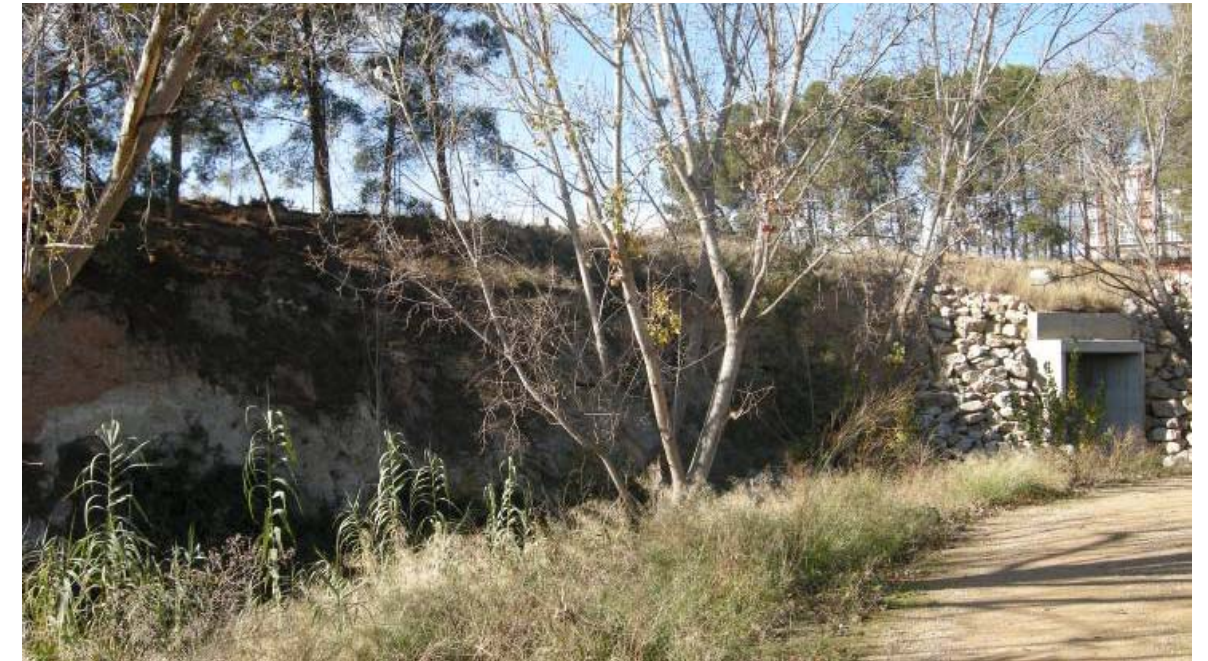
Fuerte talud rocoso situado en la margen izquierda del río
