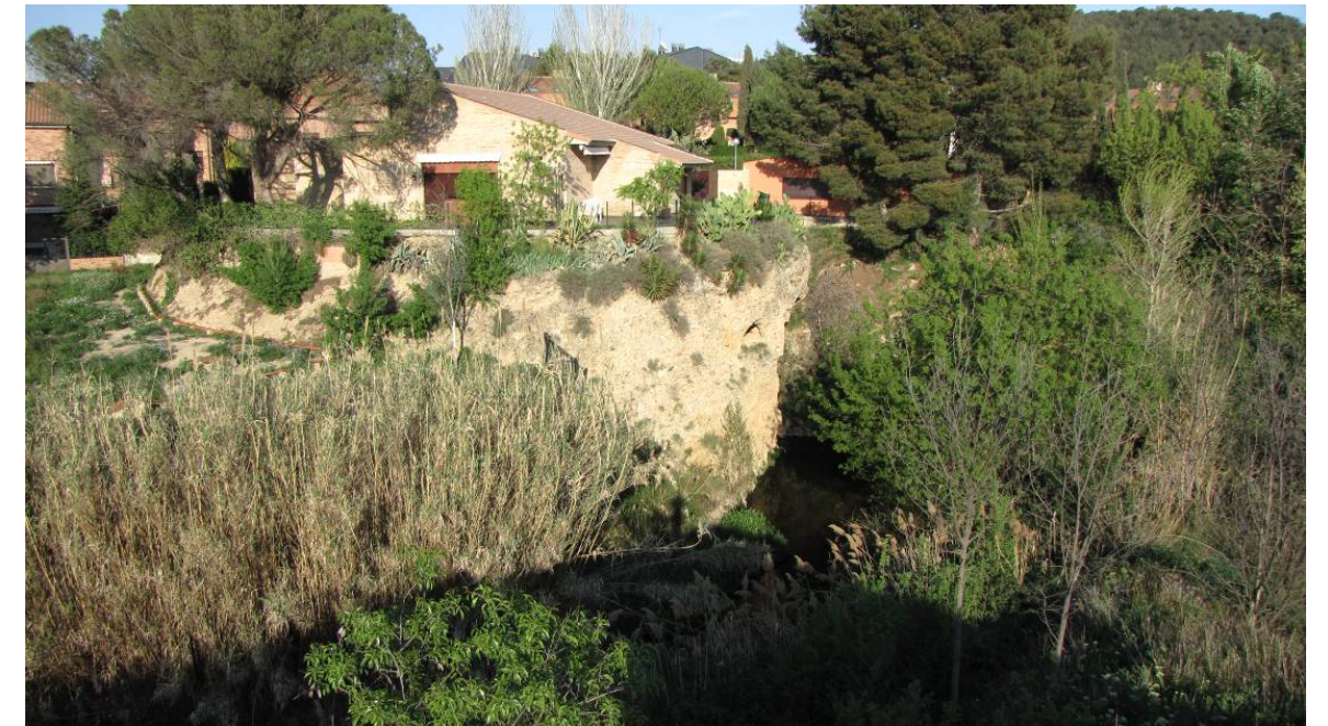
Gran desnivel existente, se observan fresnos, chopos y olmos situados entre los carrizos
