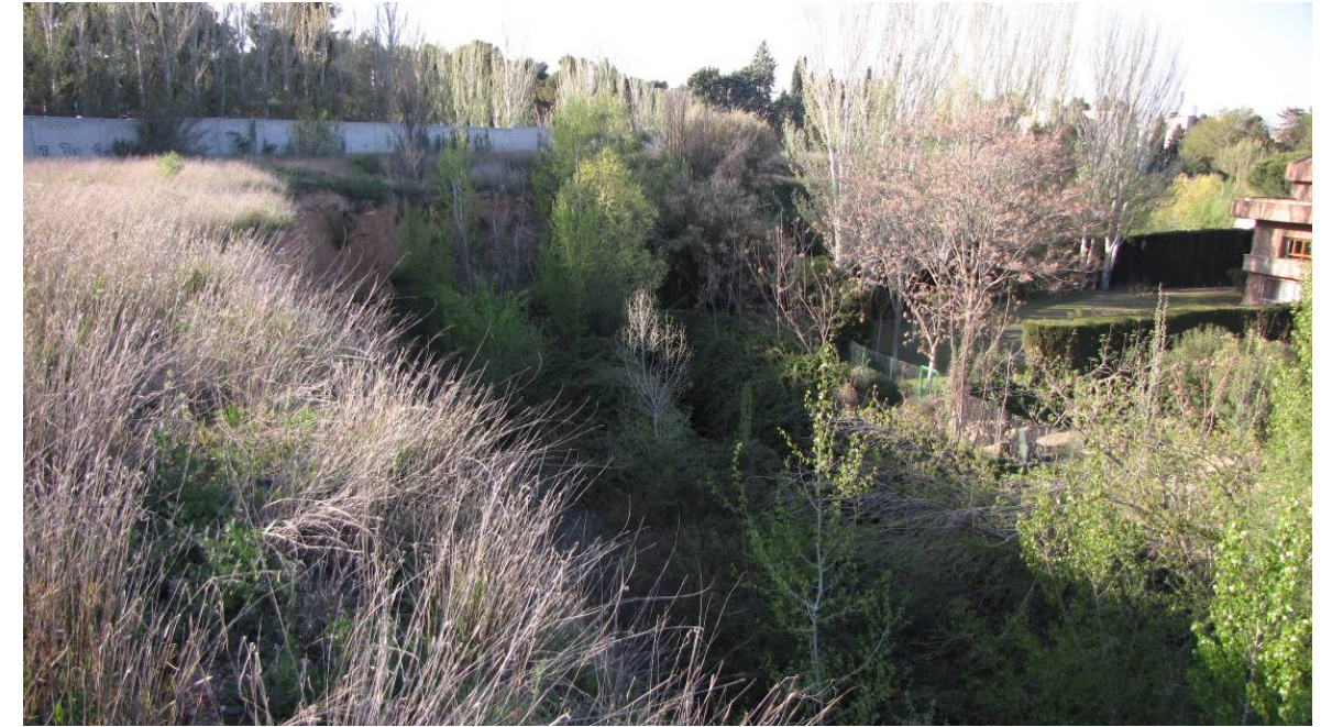
Fuerte desnivel entre la cota del terreno y el cauce del río en la parte trasera del Stadium Casablanca. En ocasiones los propietarios de las viviendas han invadido las márgenes del río y han realizado plantaciones
