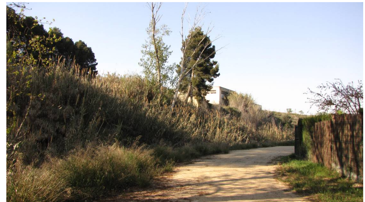
Camino de paseo que rodea la urbanización y que se sitúa junto al río (en la fotografía no se observa el cauce, se intuye por los carrizos). En la margen izquierda se observan los fuertes taludes existentes
