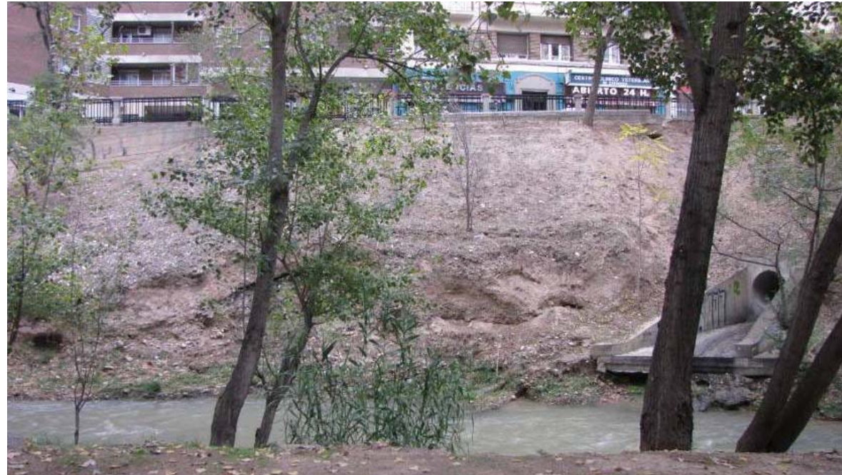
Fotografía tomada desde la margen izquierda, se observa el talud desnudo sin vegetación
