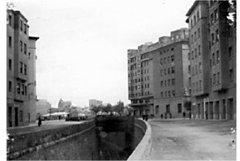
Trazado del ferrocarril bajo la avenida Goya, antes de su cubrición. (Fuente: Rafael Castillejo)
