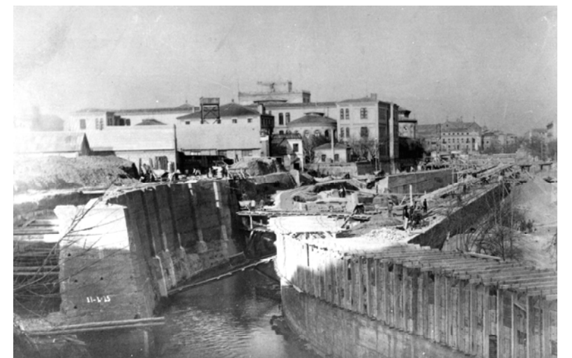
Muros para la cubrición del Huerva en Gran Vía, en el año 1925. (Fuente: Carlos Blázquez)
