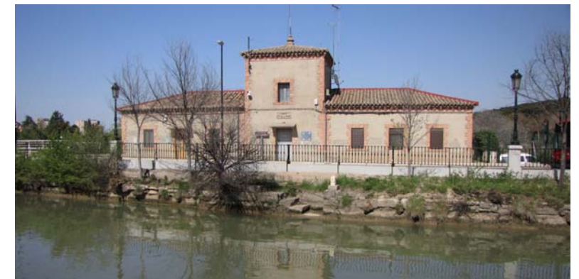
Estado actual de la Almenara y el Canal Imperial de Aragón
