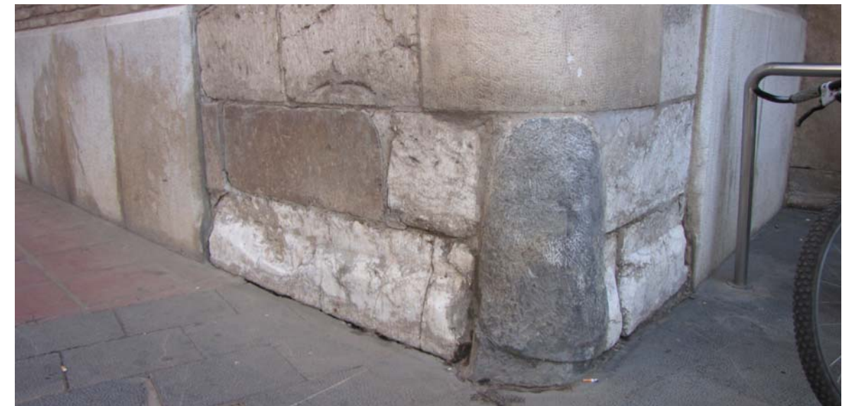
Restos de Alabastro como cimientos de un palacio antiguo de Zaragoza. Este material fue muy utilizado en la construcción de los edificios de la ciudad antigua de Zaragoza, tanto en las murallas romanas, como en edificaciones civiles. Por esta piedra fue llamada Zaragoza en la Edad Media, la "Ciudad Blanca".
