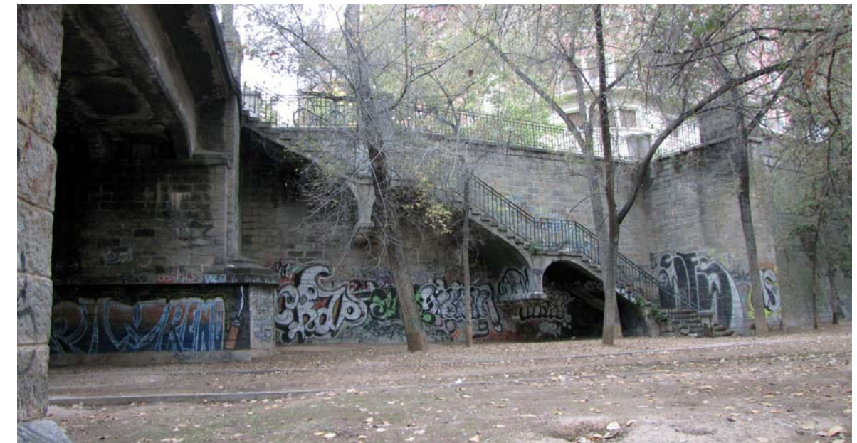
Imagen del entorno del puente Emperador Augusto, o puente de los Gitanos, y el muro de contención vertical del comienzo de la calle Alférez Provisional. La discontinuidad física, visual y sonora entre la cota superior de ciudad y la cota inferior del río produce la degradación de las zonas verdes del río.
