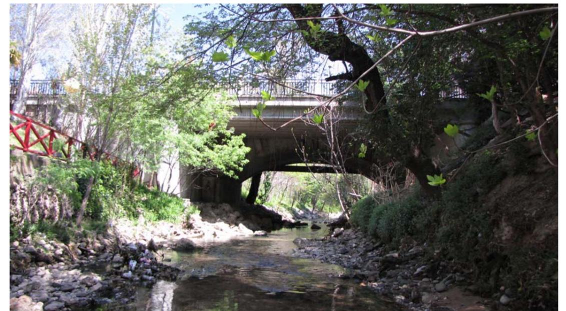
Imagen del puente de la calle Miguel Servet sobre el río Huerva. A la izquierda las zonas verdes del Centro de Mayores Lain Entralgo. Si se observa con detenimiento se puede apreciar el puente antiguo de sillería en el centro del puente y la ampliación de sus laterales. Un espacio sugerente para actividades y usos creativos.
