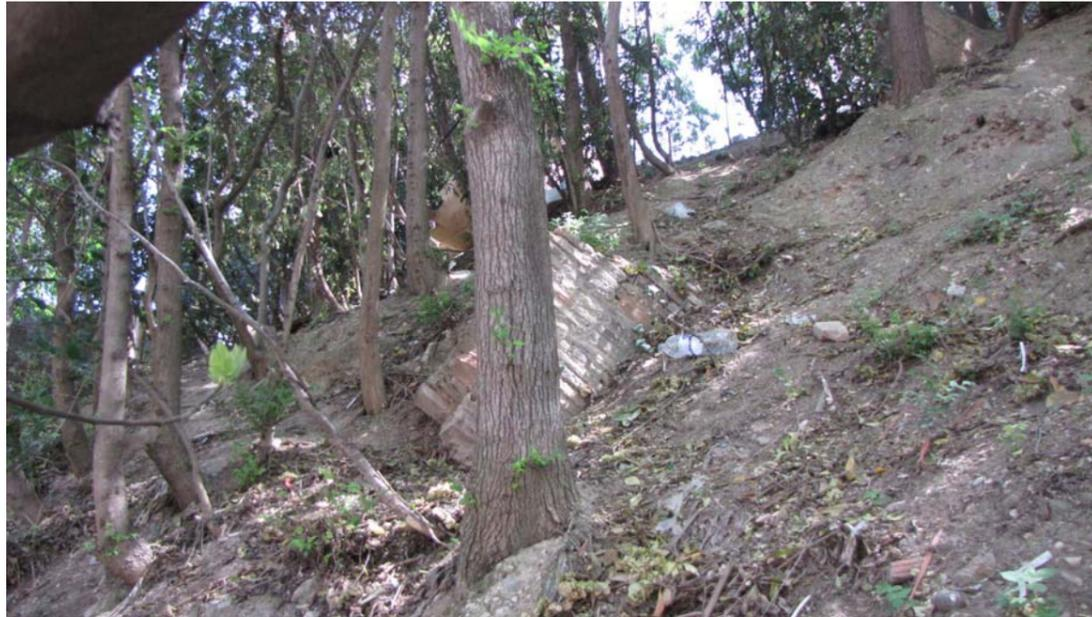
Talud en el entorno de la PIM San Miguel. Se puede observar que se trata de un talud artificial, configurado por material vertido con desechos de material de obra, así como con la presencia de muros anteriores. La vegetación de poca edad a vegetalizado este talud. Como se ha expuesto es necesario hacer un análisis geotécnico de los taludes para conocer su naturaleza y sustituir todo el material que impida un desarrollo natural seguro
