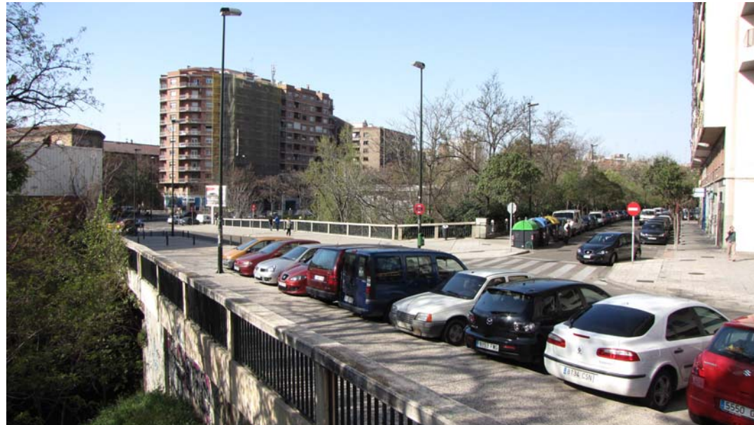
Estado actual del tramo 37. Foto tomada en el punto de recepción de la pasarela. Al fondo la calle Coimbra, del tramo 38, en la que se propone el trazado por la acera junto al río, y la sustitución de la zona de aparcamiento para la introducción del carril bici.
