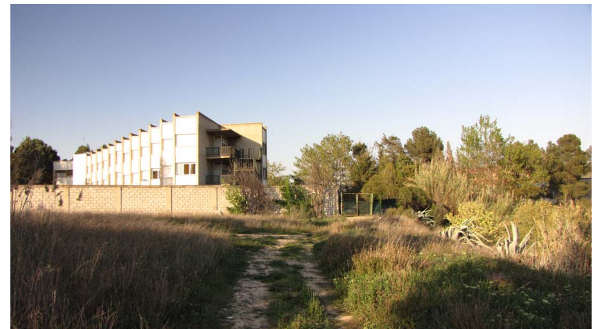
Final del tramo 8 que muere en el límite del equipamiento residencial.
