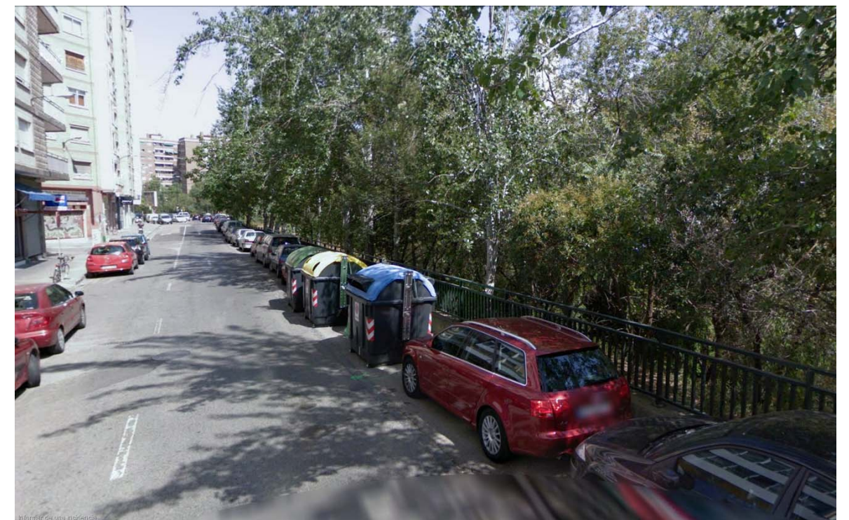
TRAMO 24 MANUEL LASALA. APARCAMIENTO EN LADO DERECHO DE CALZADA. AUSENCIA DE ACERA
