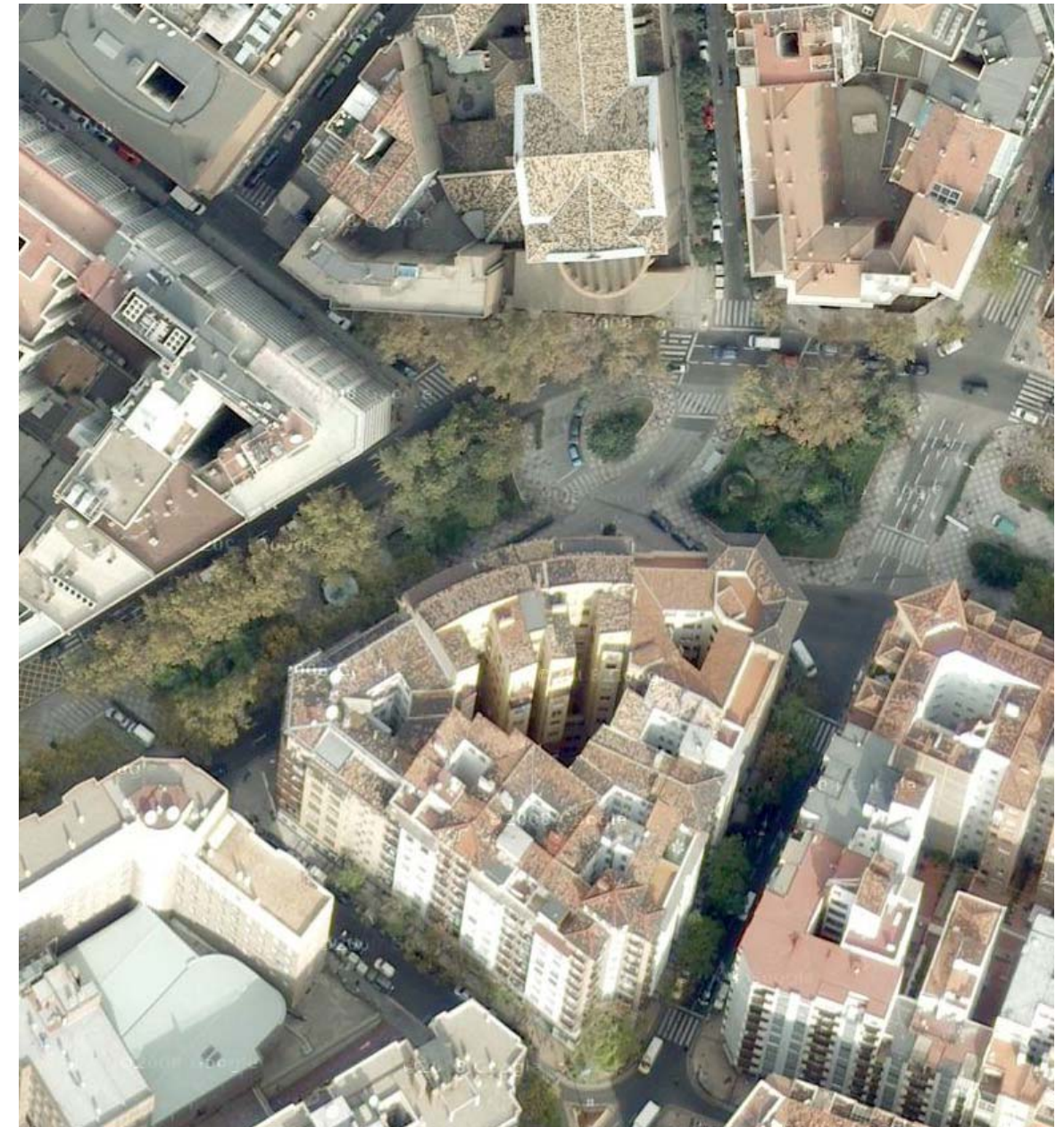
Ortoimagen del actual punto de discontinuidad del bulevar central de Paseo Constitución.
