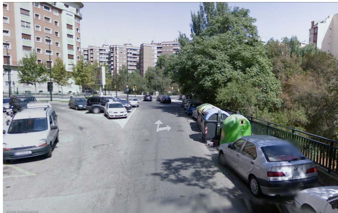
TRAMO 24 MANUEL LASALA. APARCAMIENTO EN LADO DERECHO DE CALZADA. AUSENCIA DE ACERA
