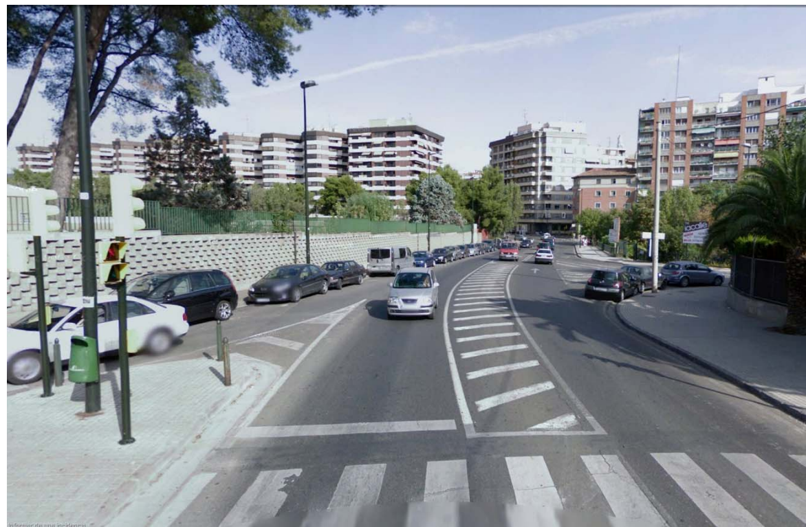
TRAMO 19 PASEO RENOVALES. APARCAMIENTO EN ACERA IZQUIERDA.
