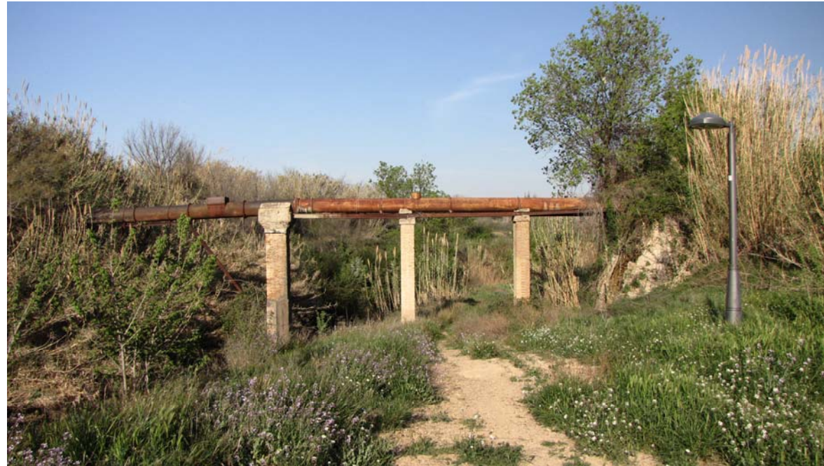
Final actual del andador perimetral al límite de la urbanización Fuente de la Junquera. En este punto se propone la ejecución de la pasarela.
