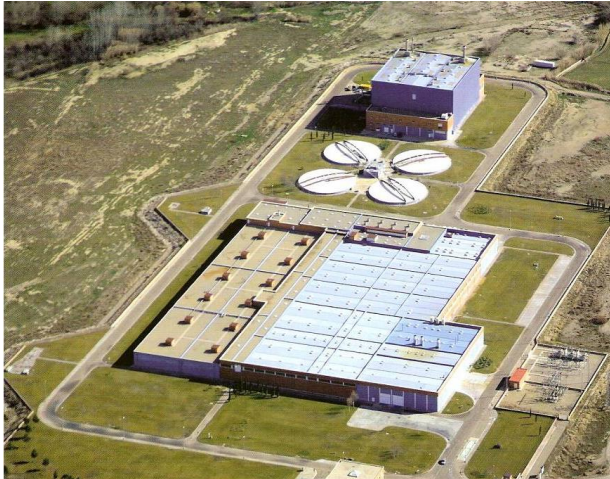
Fig.1 El sistema de cerramiento y desodorización de la Depuradora de La Cartuja, la hace muy diferente de cualquier EDAR convencional
