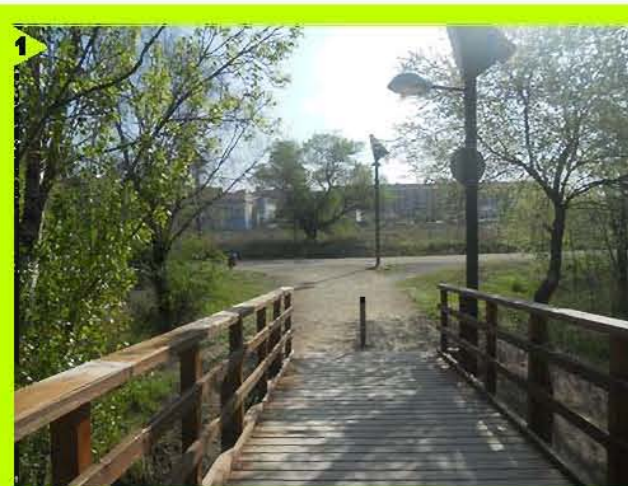
KM 7.8 Pasarela sobre el Gállego en Santa Isabel
