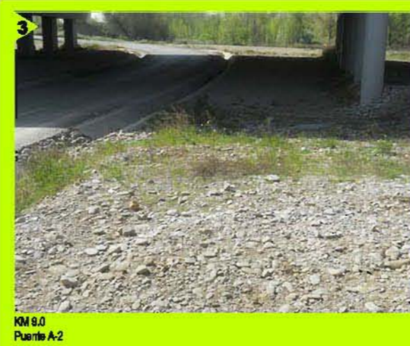
KM 9.0 Puente A-2
