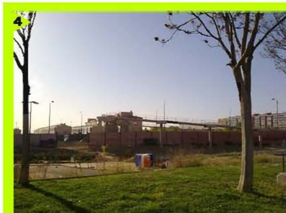
KM 21.9 Pasarela sobre la Av. Pirineos en Parque Goya
