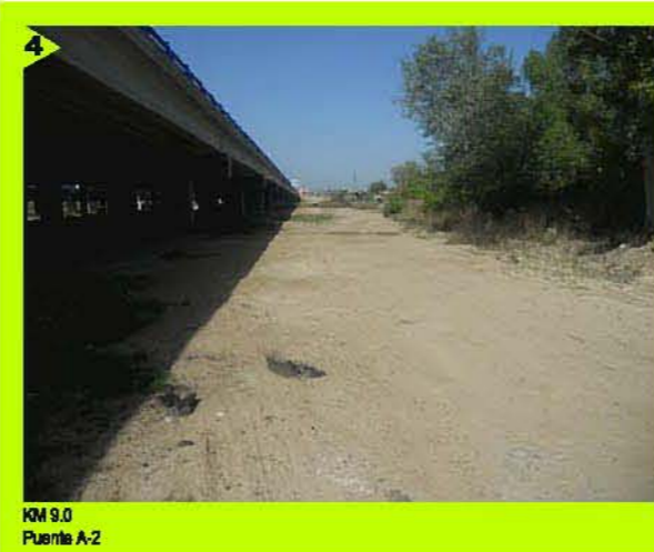
KM 9.0 Puente A-2
