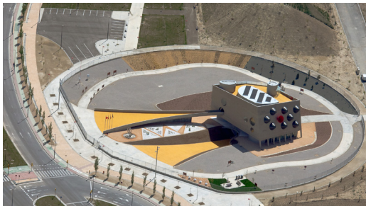
Centro de Urbanismo Sostenible y Eficiencia Energética de Valdespartera (C.U.S.)
