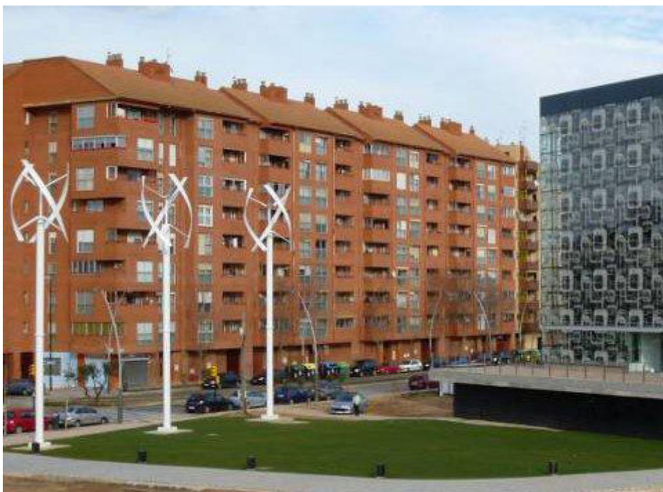
Centro de Incubación Tecnológica (Edificio Cero Emisiones)
