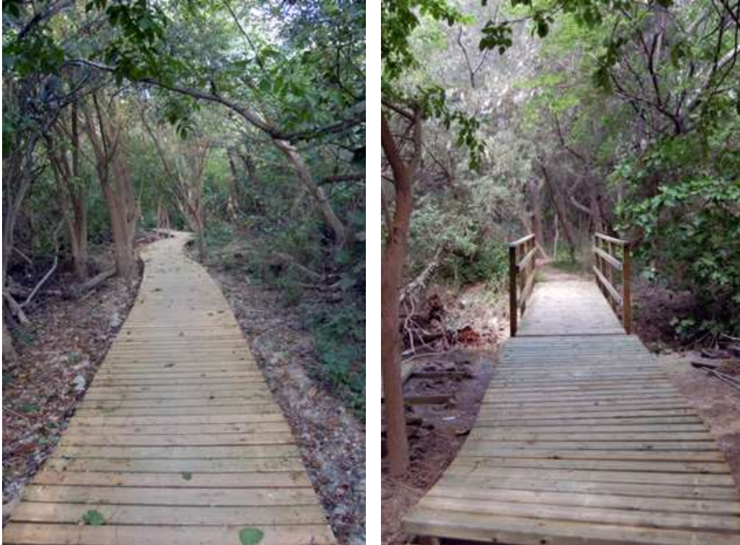
Pantalán y pasarela construida en el Corredor del Gállego
