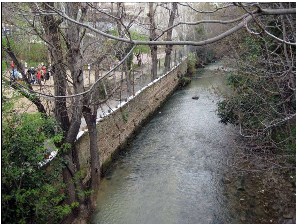
Imagen en la que se aprecia el muro que separa el parque del río y el estado en que esta zona se encontraba antes de la intervención LIFE
