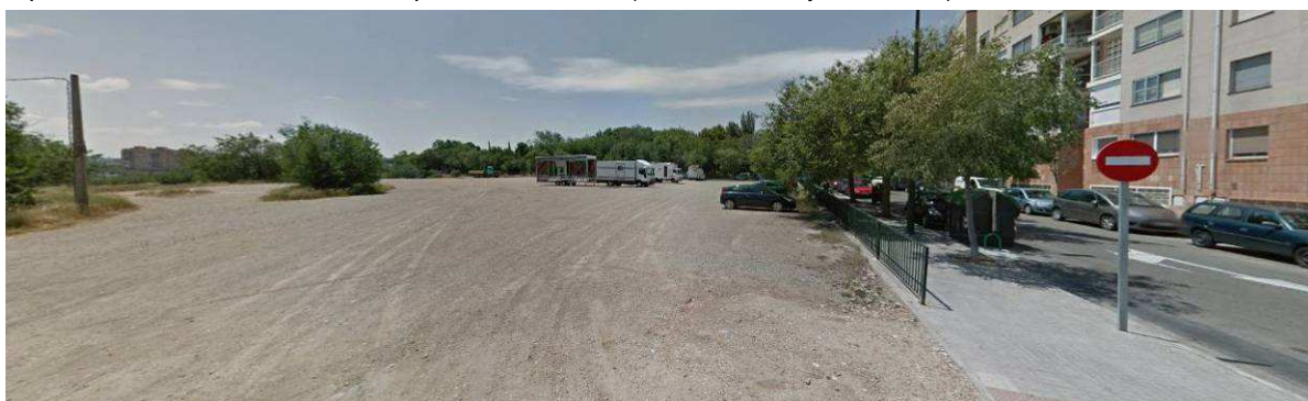
Fig.92: Parcela de sistema general zona verde. Uso actual como área de aparcamiento.
