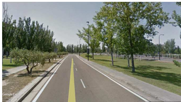
Fig.78: Grandes bandas encespedadas entre la vía de servicio y la N330.
