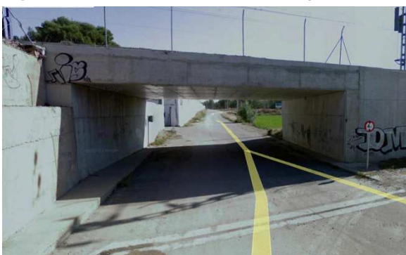
Fig.74: Paso bajo el ferrocarril en la glorieta de la Hispanidad.
