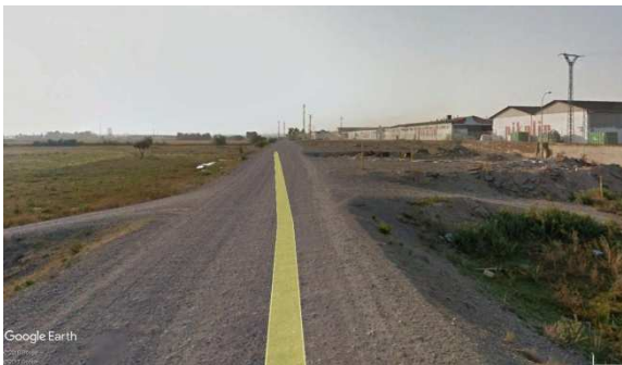
Fig.138: Camino Torre Condesa. Contacto del polígono con Huerta Honda. Vertidos y basuras.
