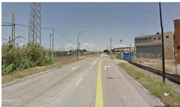
Fig.82: Calle Benjamín Franklin. Zonas verdes sin tratamiento.
