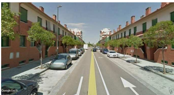
Fig.122: Calle San Antón. Calle tipo desarrollo residencial de vivienda unifamiliar.
