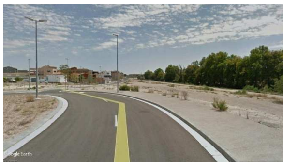
Fig.115: Zona verde sin tratamiento junto al Canal Imperial.
