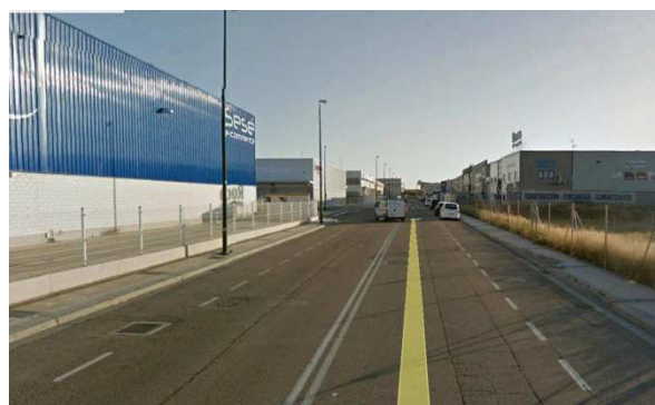
Fig.85: Calle Monasterio Descalzas Reales. Ausencia de arbolado y vegetación.
