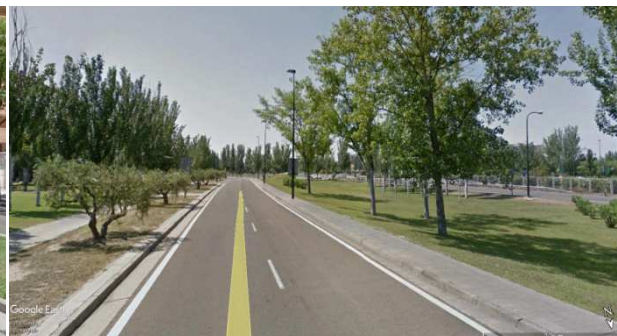
GRANDES BANDAS ENCESPADAS ENTRE LA VIA DE SERVICIO Y LA N330
