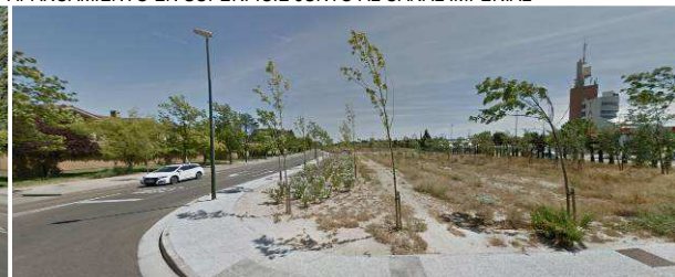
CORREDOR OLIVER SIN TRATAMIENTO. VISTA HACIA EL SUR
