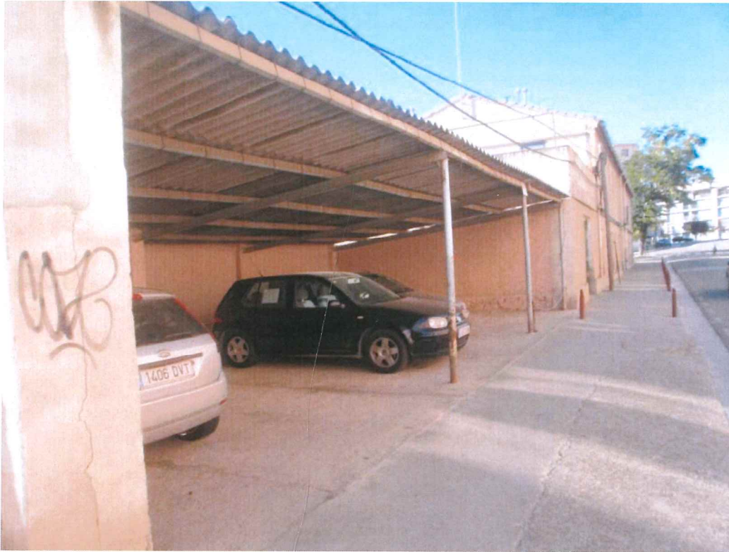
7- Aparcamiento anexo también al cuartel
