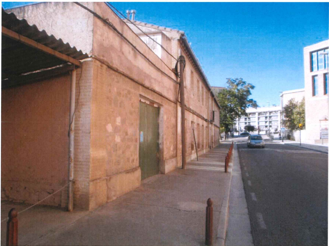
6-Edificación anexa al cuartel
