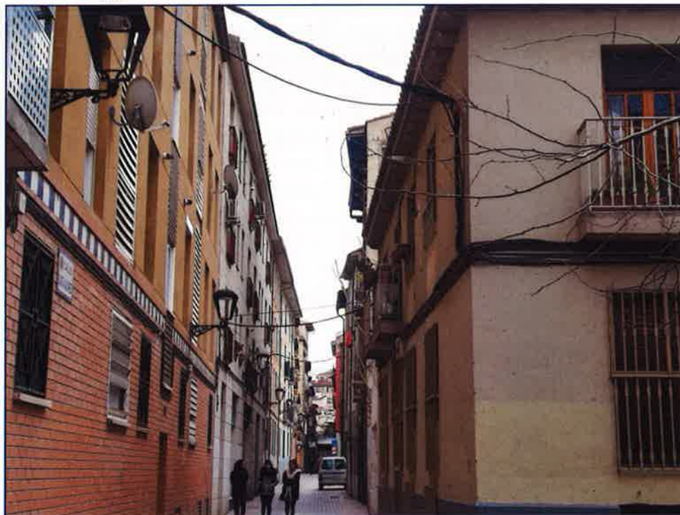
Tendidos aéreos sobre la calle de Casta Álvarez (conjunto de interés cultural)
