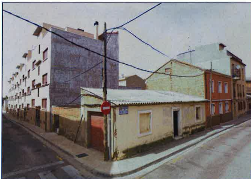
Tendido aéreo sobre postes de madera en el barrio de Valdefierro
