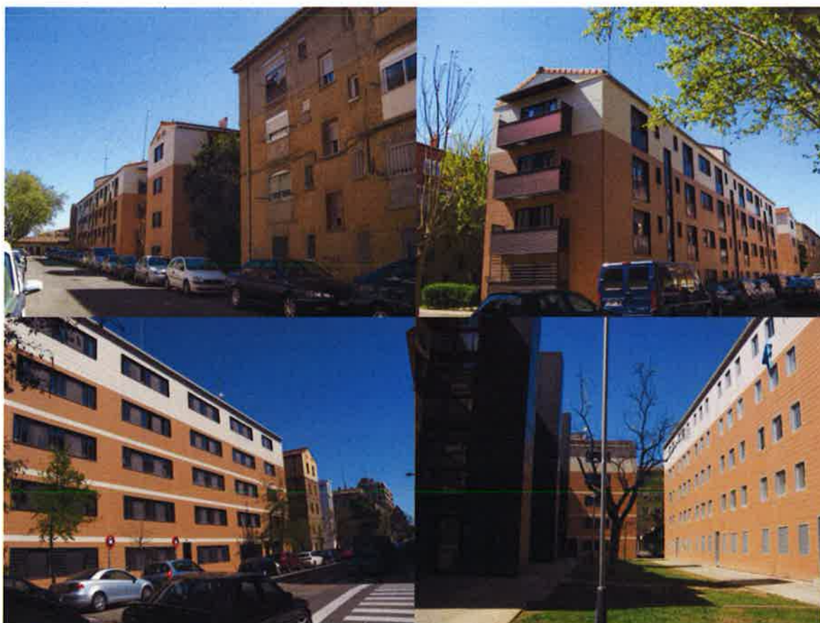
Fachadas original y reformadas en los grupos sindicales Girón/Casamayor I –arriba- y II –abajo- (Las Fuentes)
