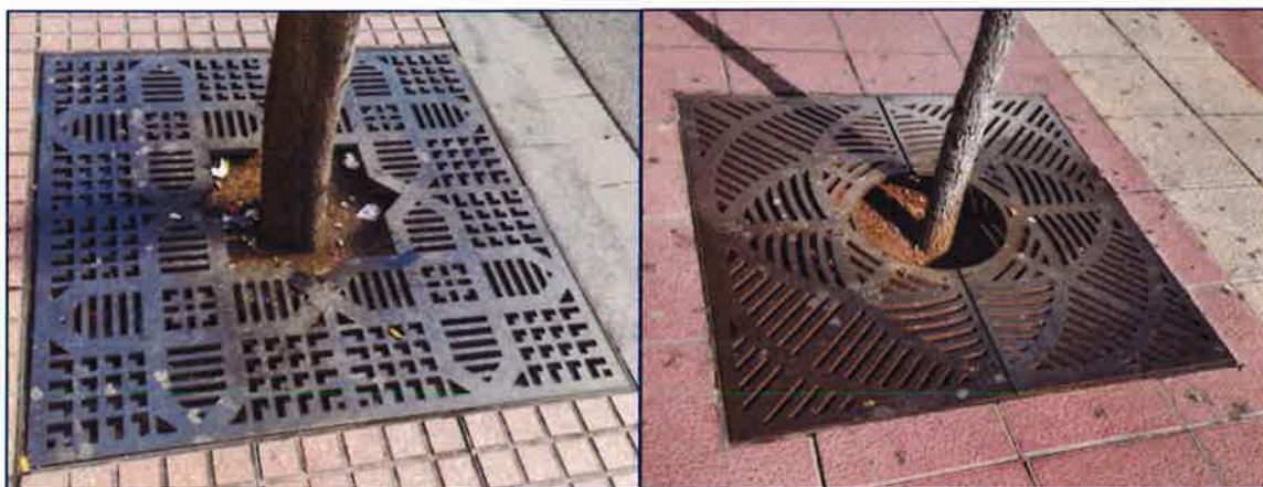
Alcorques de hierro fundido en la calle del Conde de Aranda y el paseo de las Damas
