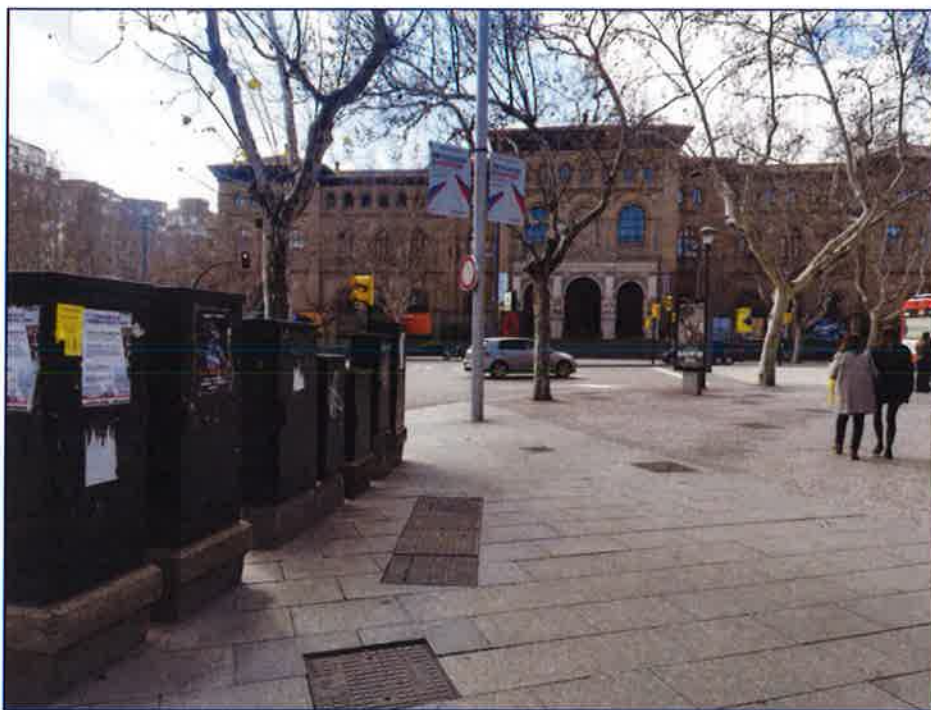
Armarios de instalaciones en la plaza de Aragón (entorno del Paraninfo y Capitanía)
