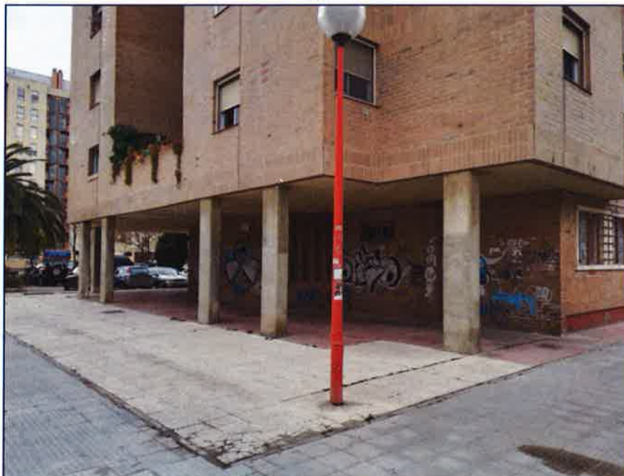
Estructura de hormigón vista en un porche del Actur
