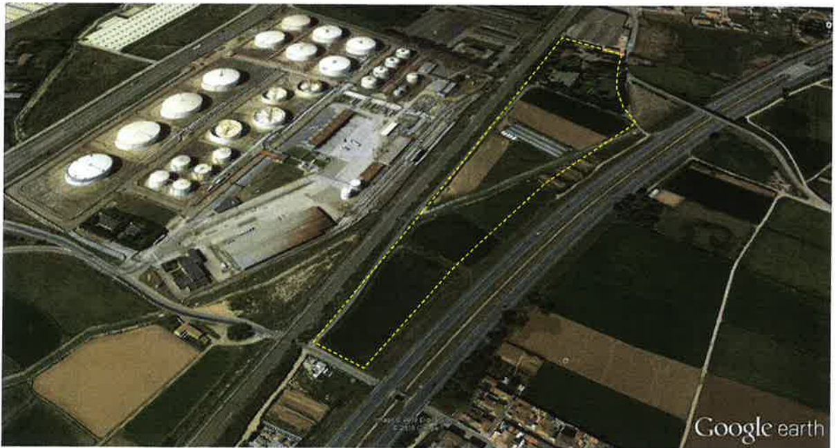
1.- Fotografía aérea. Ámbito de la modificación aislada (fuente: Google earth)
