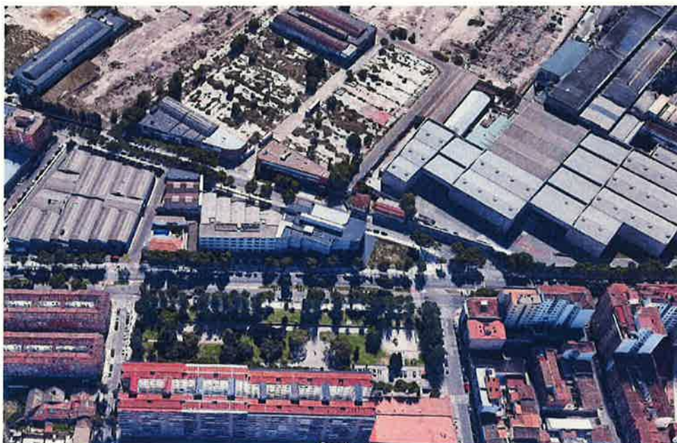
Vista de las parcelas afectadas por la Modificación desde el Oeste (Avenida de San Juan de la Peña).
